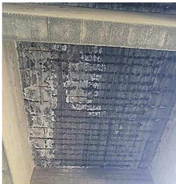
Inoltre, l'impalcato non è impermeabilizzato e l'umidità rimane a lungo ed in gran quantità tra la soletta ed il cls della pendenza, come riscontrato nel corso dei saggi effettuati nell'anno 2017, peggiorando la situazione.
