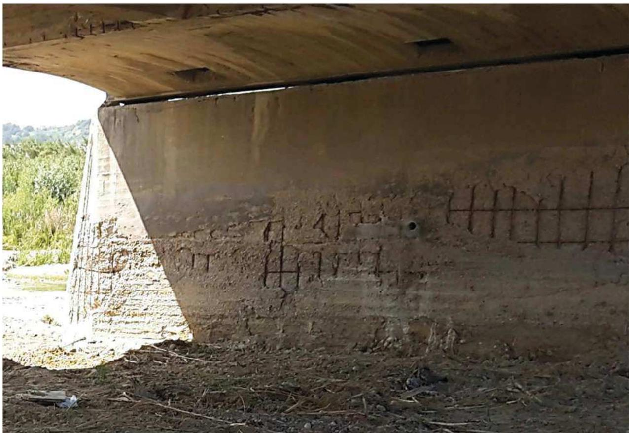
mentre il calcestruzzo delle pile n. 6-7 è completamente ammalorato,
